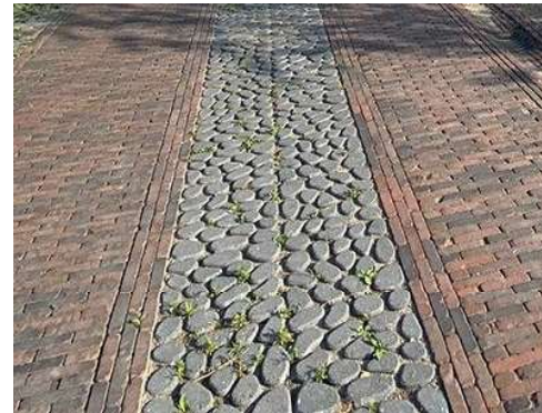
toegangsweg als 'karrespoor' klinkers met keigrasstenen
