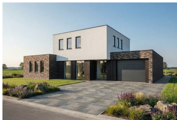
Twee bouwlagen met plat dak, circa 480 m 3
