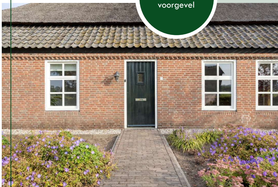
Officiële entree in voorgevel
