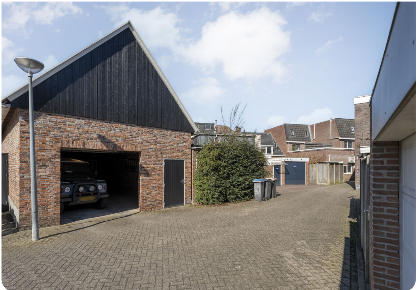
Doorloophoogte van ruim 2 meter onder de balken
