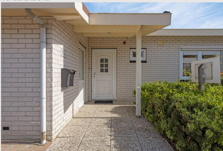
Zugang zum Haus mit überdachtem Eingangsbereich.
