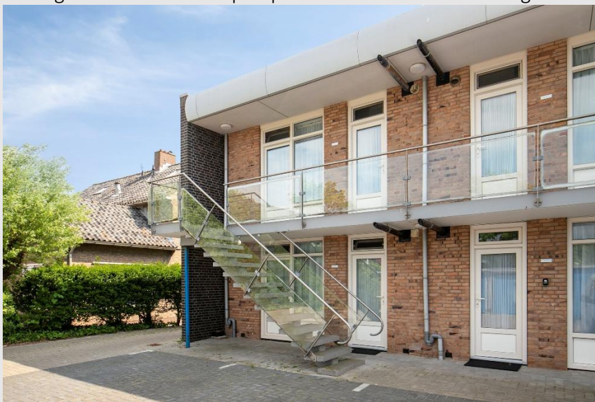
Middels de trap toegang tot het appartement.
