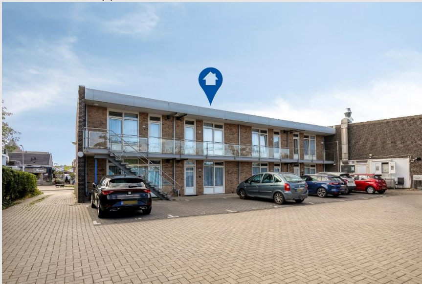
Hintenansicht wohnung gebäude.
