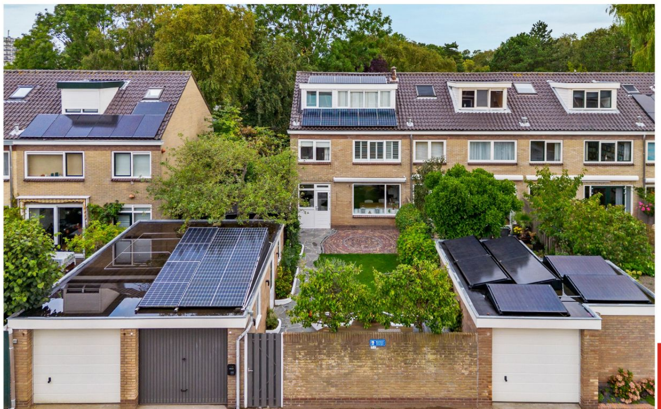
GARAGE EN LAADPAAL
