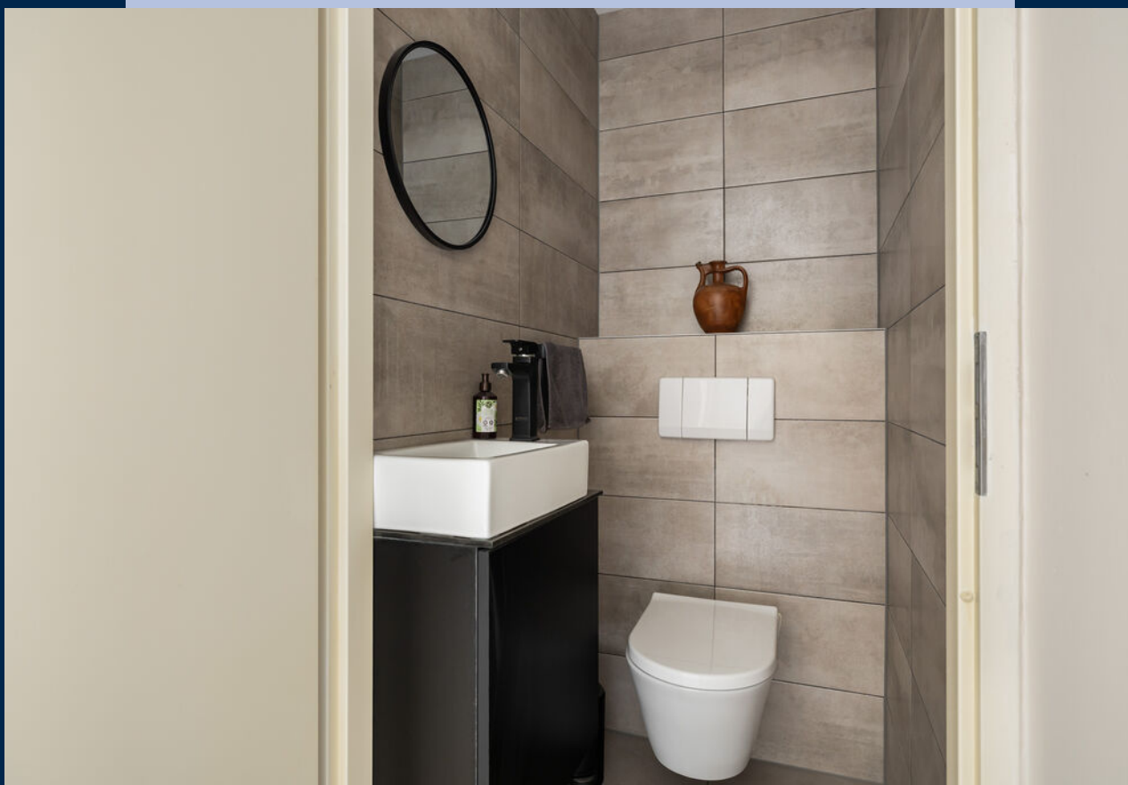
Op de overloop bevinden zich daarnaast een separaat toilet en opstelplaats van de cv-ketel uit 2021.
