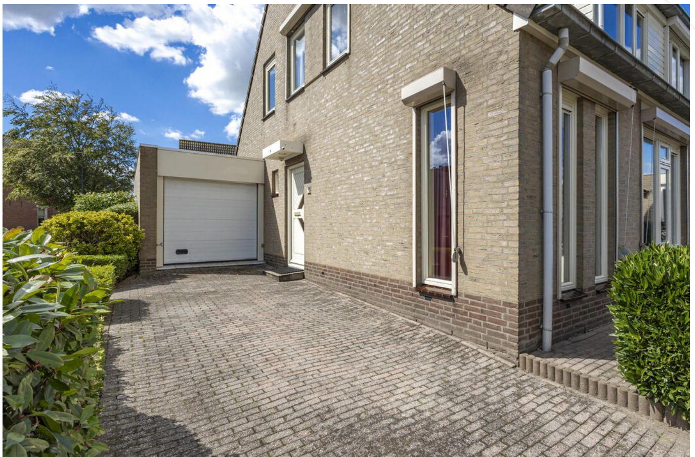
Oprit en garage
