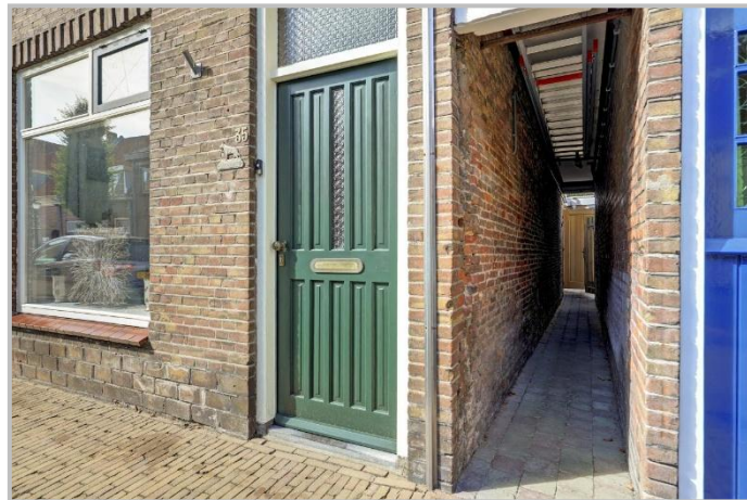
Brandgang naast de woning
