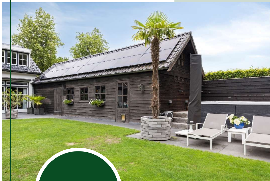
Diepe garage met pannen dak
