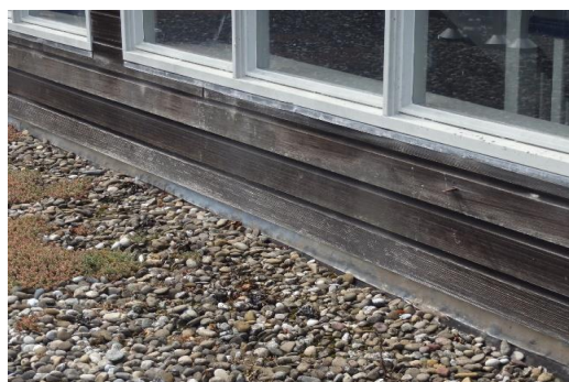
18: aanzicht opstandafwerking tpv rabatdelen
