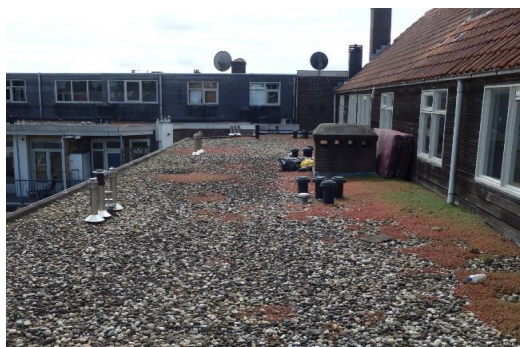
7: overzicht deel dakvlak A
