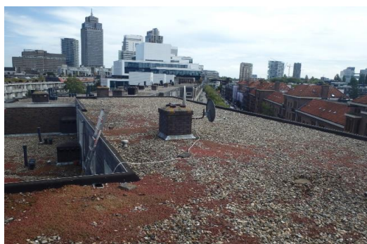
29: overzicht deel dakvlak E
