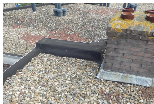
34: aanzicht dakrandafwerking tpv kopgevel
