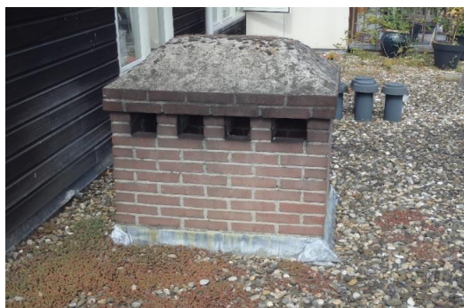
19: aanzicht gemetselde schoorsteen
