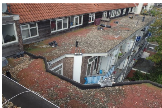
11: aanzicht deel dakvlak A en C
