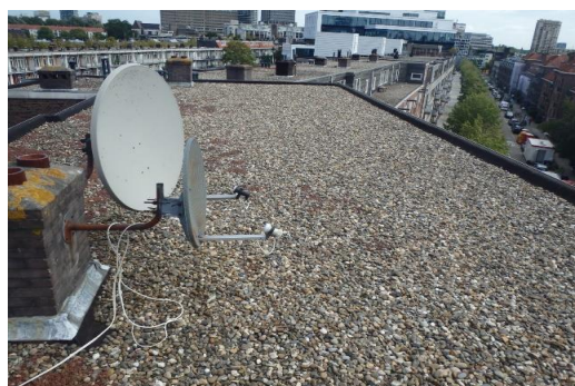
30: overzicht deel dakvlak E
