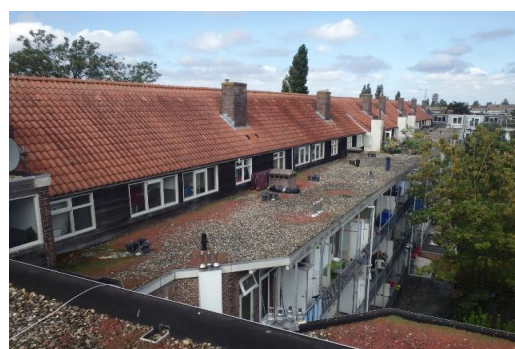
12: aanzicht deel dakvlak A
