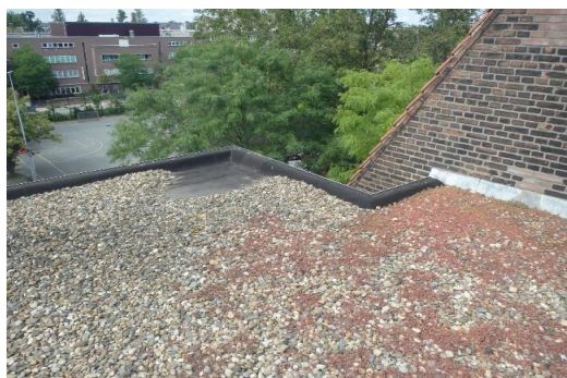
31: overzicht deel dakvlak E
