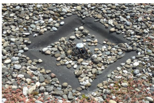
23: verdiepte hemelwaterafvoer (onderuitloop)
