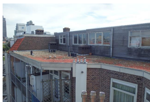
10: aanzicht deel dakvlak C
