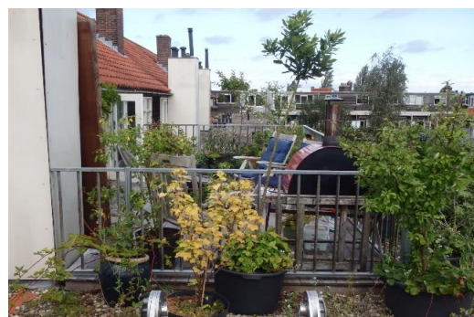
6: plaatselijk is een terras aanwezig, dakvlak A
