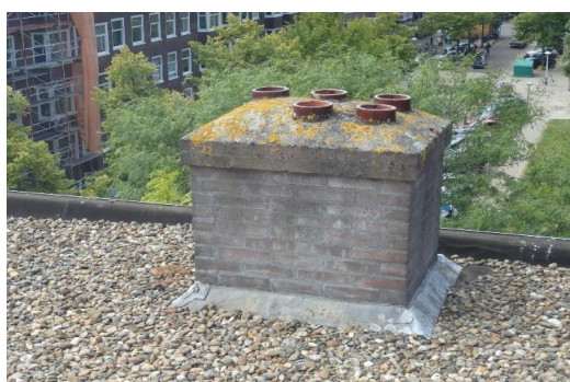
35: aanzicht gemetselde schoorsteen
