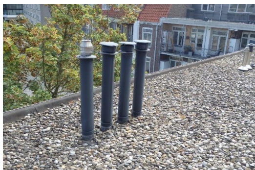
25: diverse rookgasdoorvoeren
