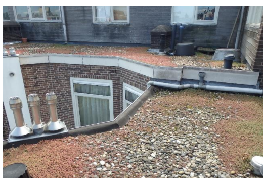
9: aanzicht deel dakvlak C
