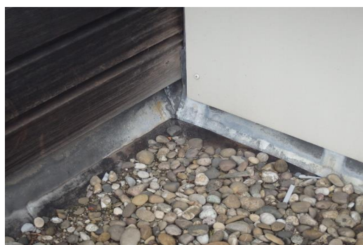
22: aansluiting diverse opstandafwerkingen
