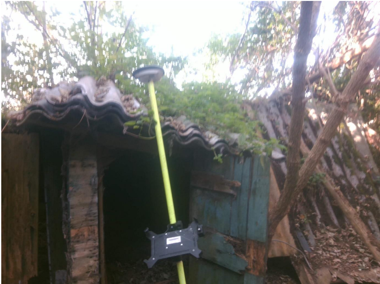
Foto 7: asbestverdacht dak
