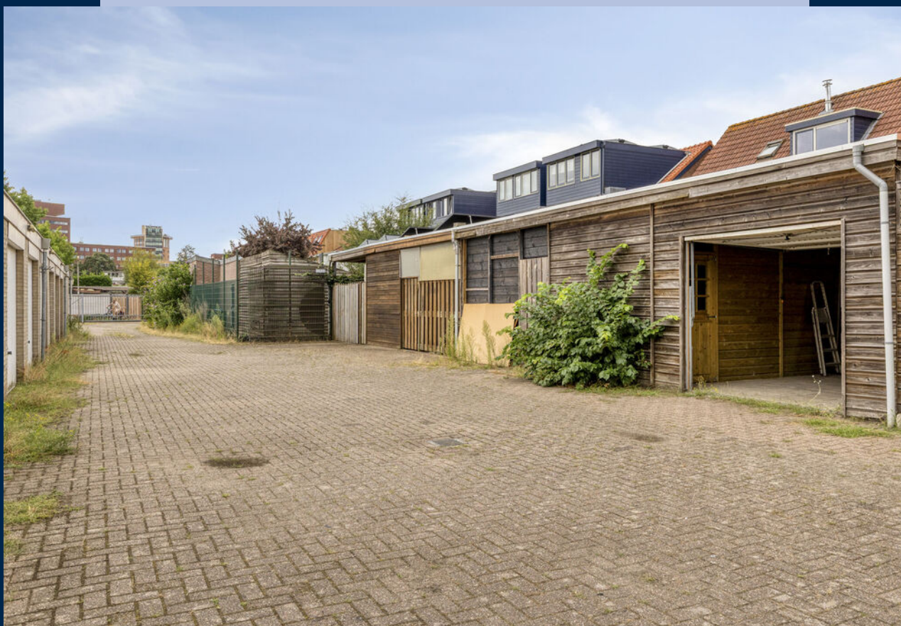
De garage, met recentelijk vernieuwd dak, is gelegen aan een afgesloten terrein dat uitsluitend toegankelijk is voor aanwonenden.
