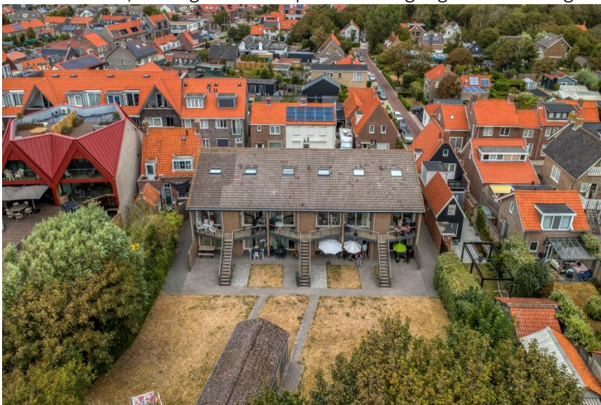
Rückansicht, Zugang zur Wohnung über die Treppe.
