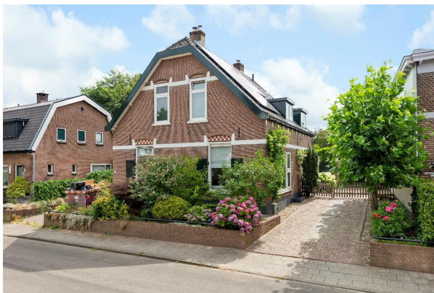
Steijnweg 51 te Oosterbeek
