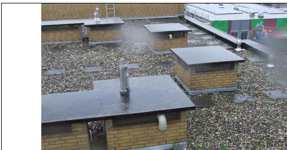
Foto 5. Parallele dakdoorvoeren
