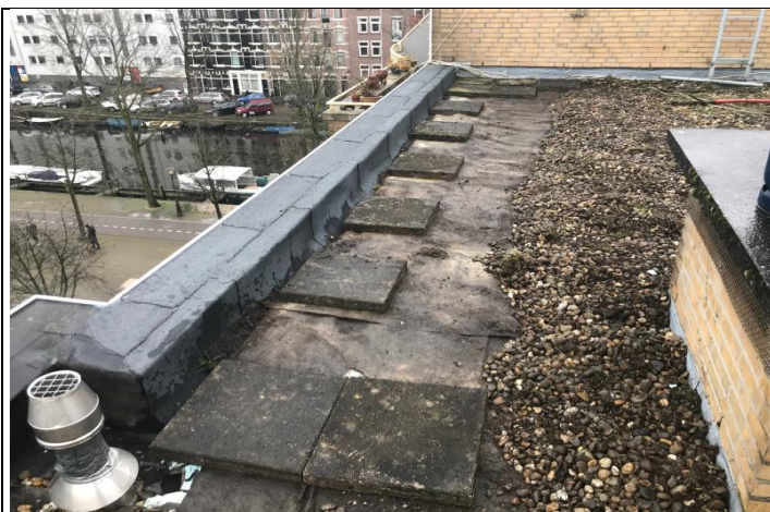
Isolatie, worteldoek en tegels teruggelegd.
