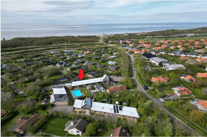
Luftaufnahme mit Lage Wohnung.
