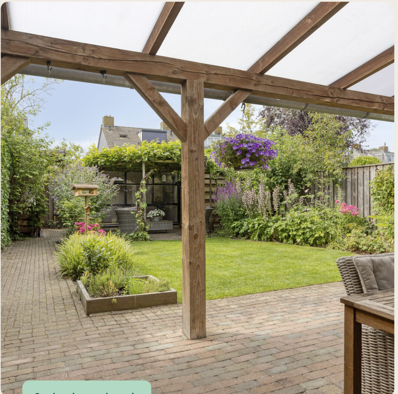
Overkapping aan de woning
