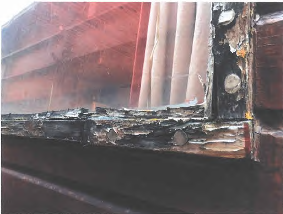
Rotte kozijnen worden vernieuwd.
