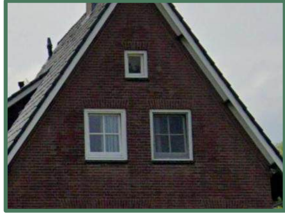
Detailfoto van de kopgevel
