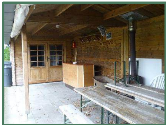
Overkapping verhard met betontegels
