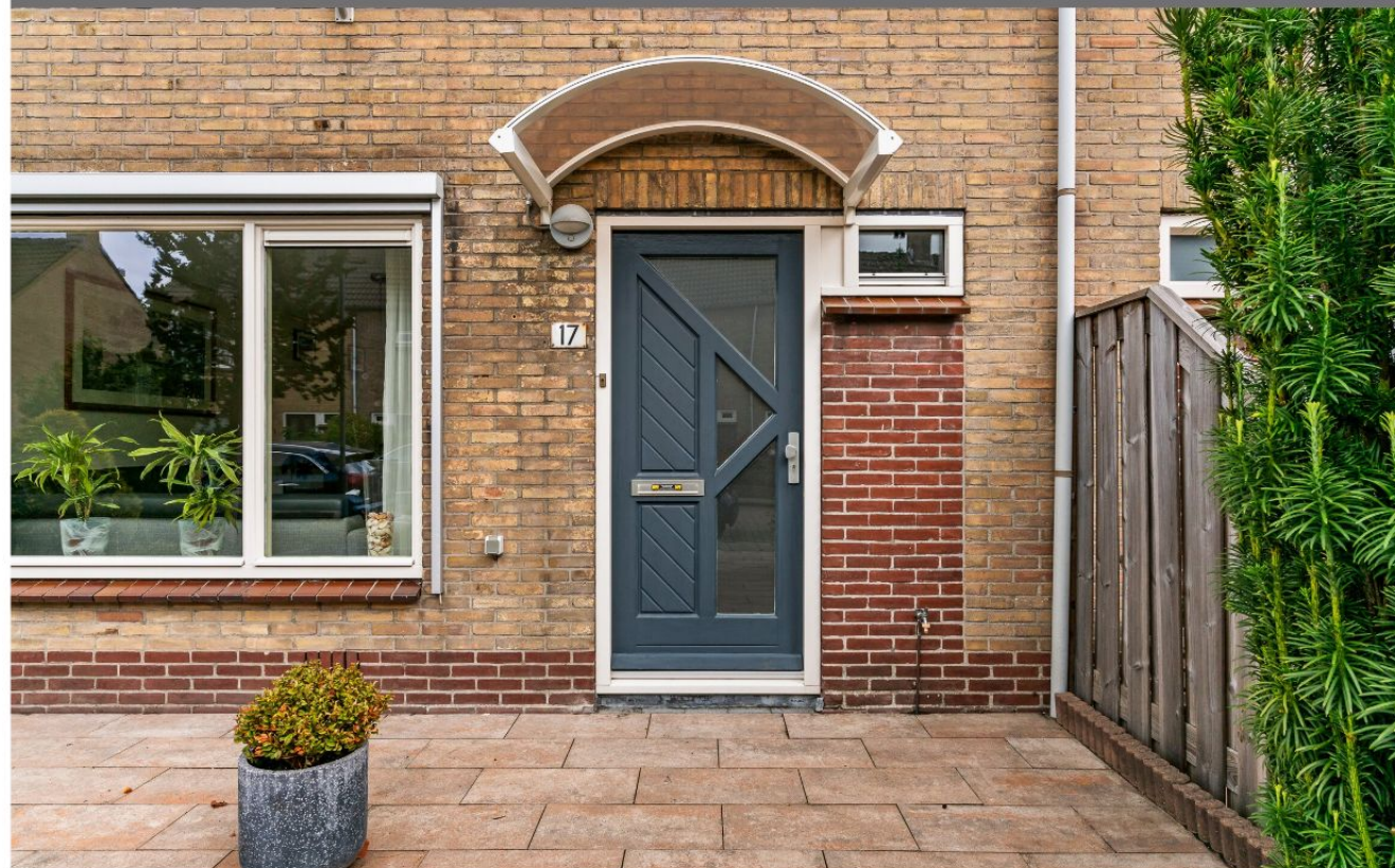
ENTREE EN TOILET
