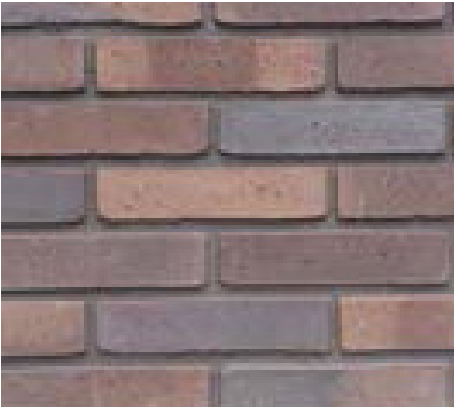
Gevelvlakken – rood antraciet
