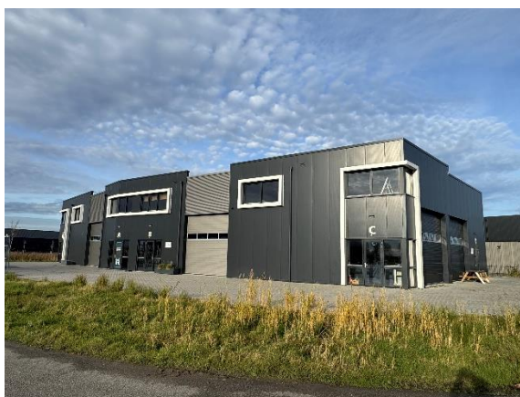
Westerpolder 4 Dronrijp - 11 units
