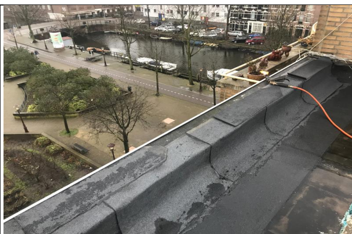
Een baan langs dakrand gebrand en vervolgens afwerkstroken tot in de trim gebrand.
