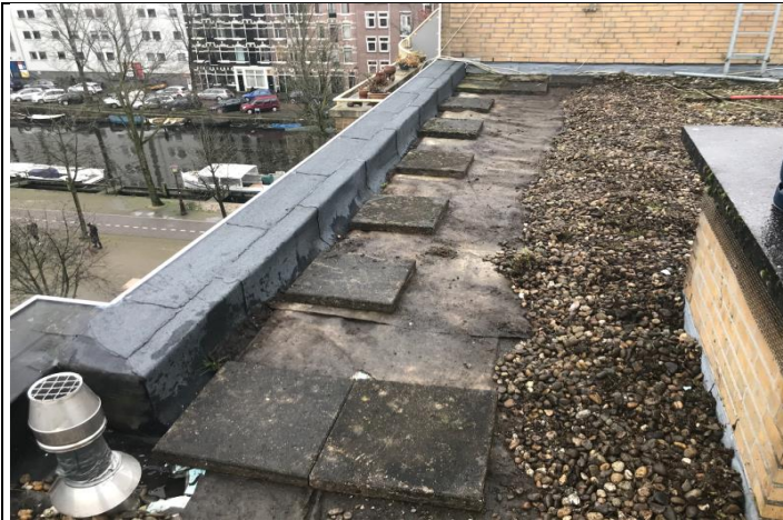
Isolatie, worteldoek en tegels teruggelegd.
