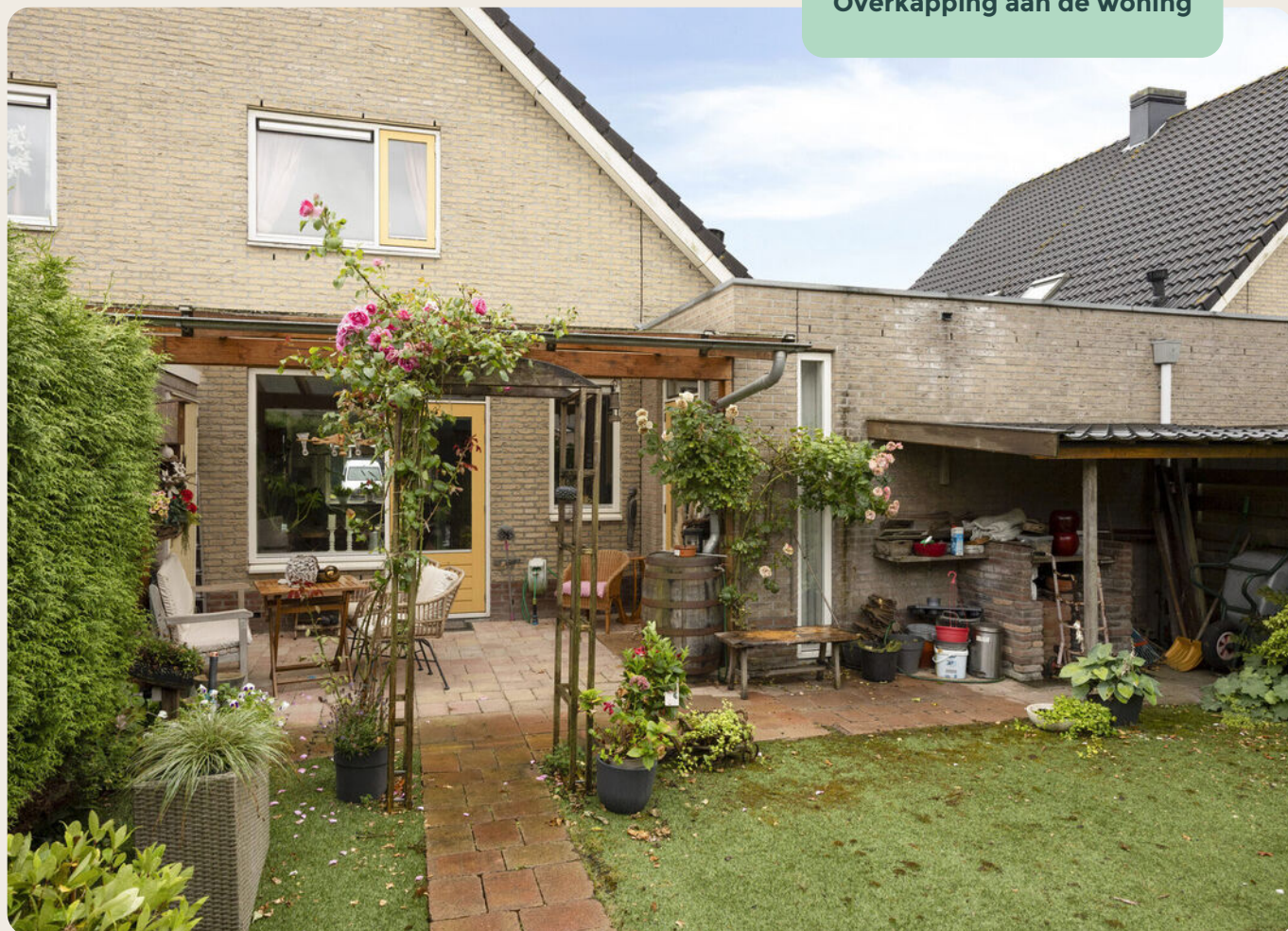
Overkapping aan de woning
