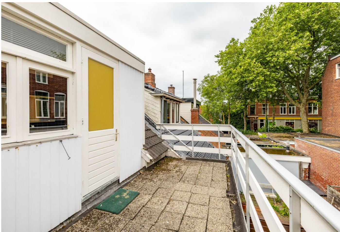
Nieuwe Blekerstraat 85, Groningen
