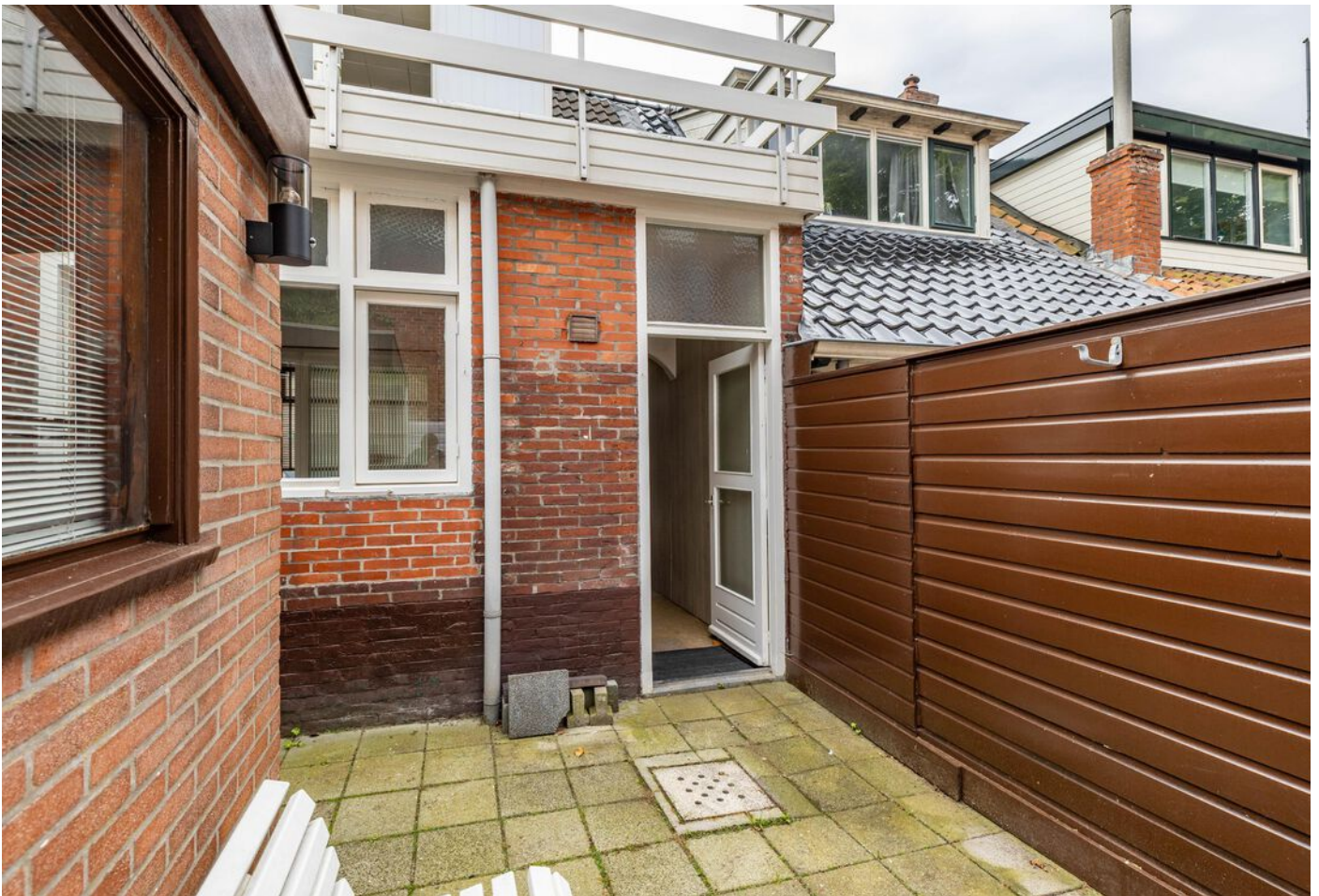
Nieuwe Blekerstraat 85, Groningen
