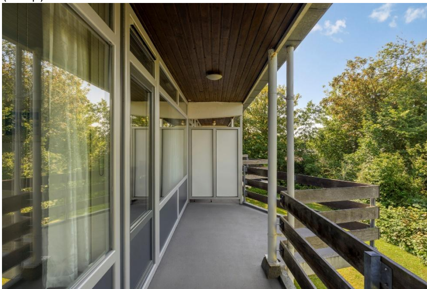
Het balkon op het zuidwesten.
