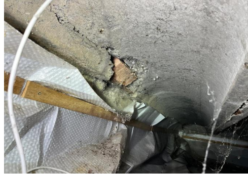
Foto 2. Scheurvorming
