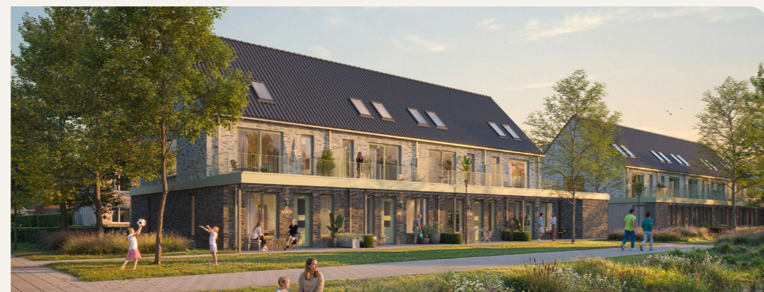
Gelijkvloerse tuinwoningen & twee-laagse terrasappartementen
