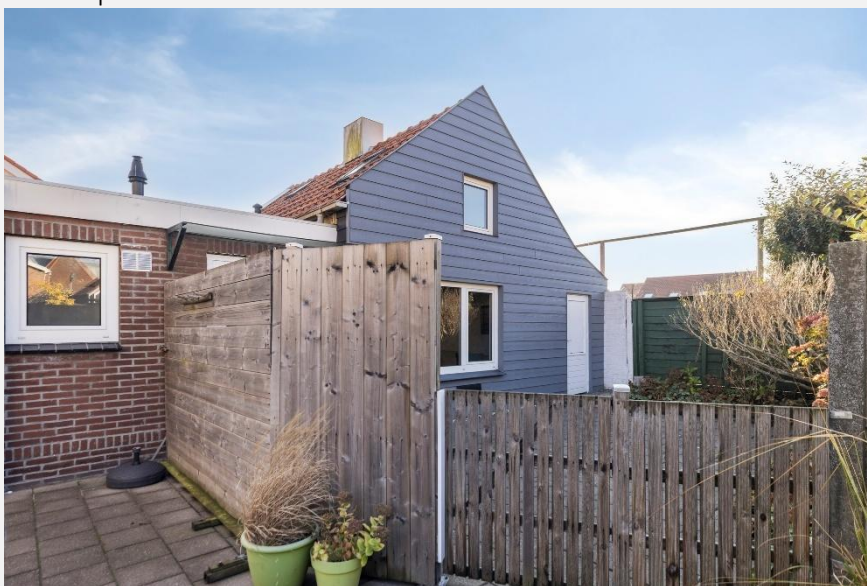
Afscheiding tussen woning en gastenverblijf.
