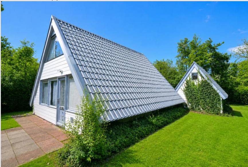
Vorder-nebenseite Ansicht von die Wohnung.
