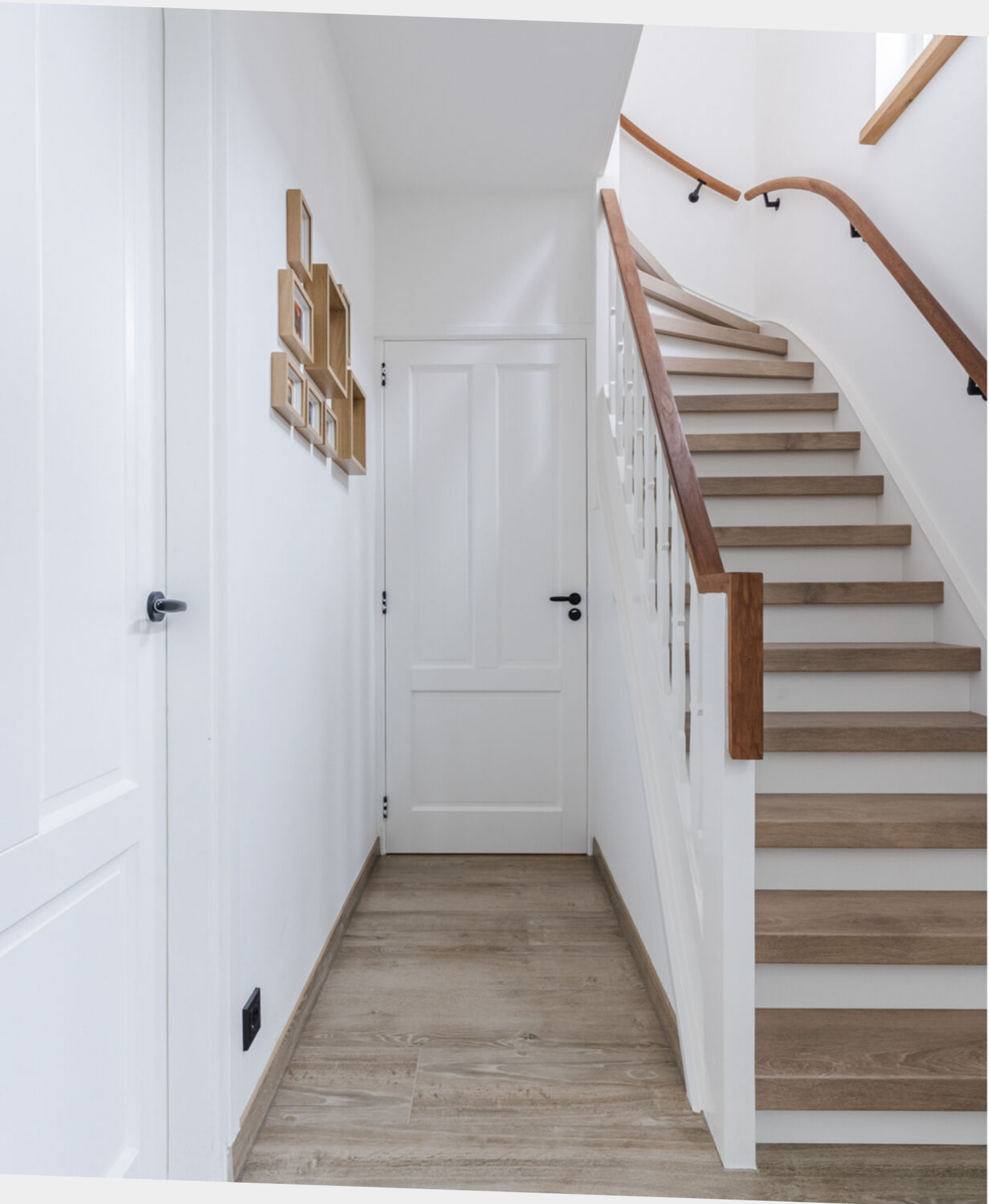
De trap is bekleed met moderne, slijtvaste HPL treden
