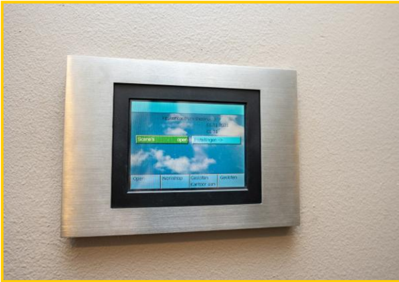
Bedieningspaneel KNX gebouwbeheersysteem.
