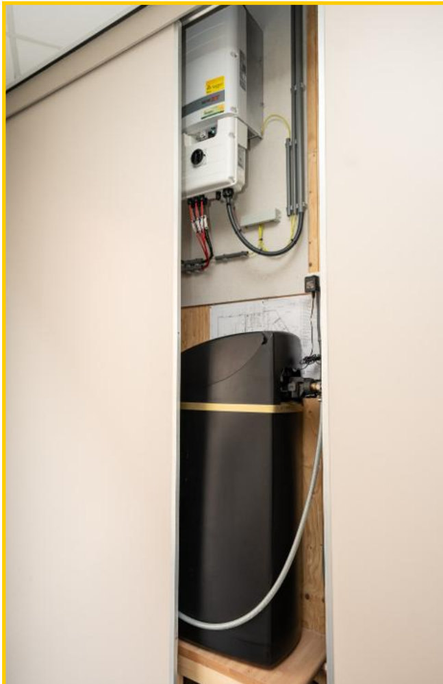
De groepenkast, het Watergenius wateroptimalisatiesysteem, de elektrameter, de watermeter en de omvormer zonnepanelen bevinden zich in de kastenwand aan de voorzijde van de showroom.
