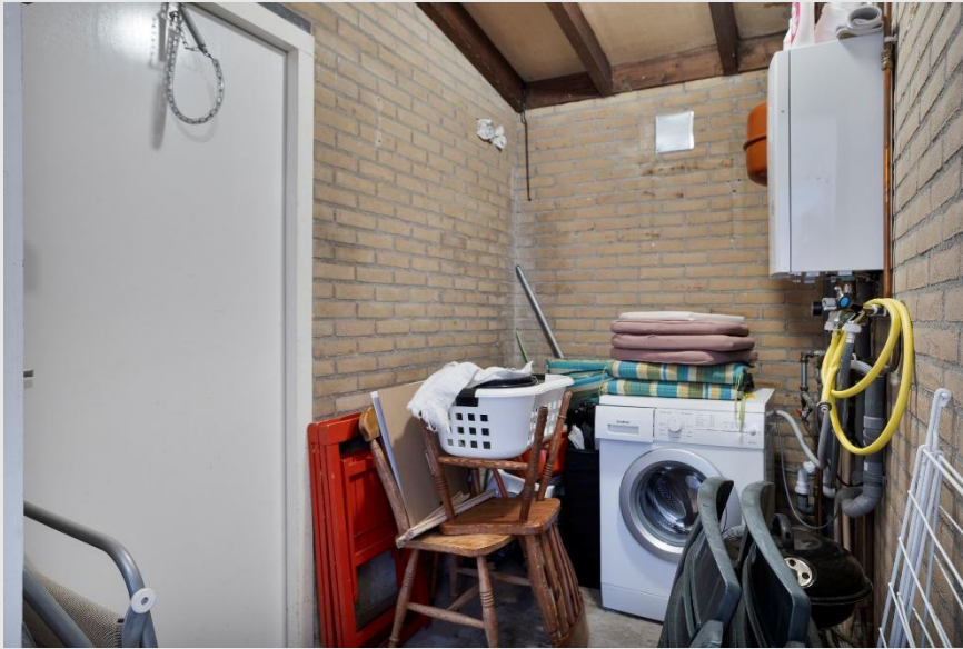
De inpandige berging met wasmachine aansluiting, c.v.-opstelling en een deur naar buiten.
