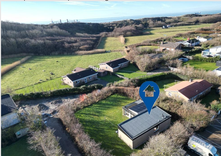
Luchtopname met ligging woning.
