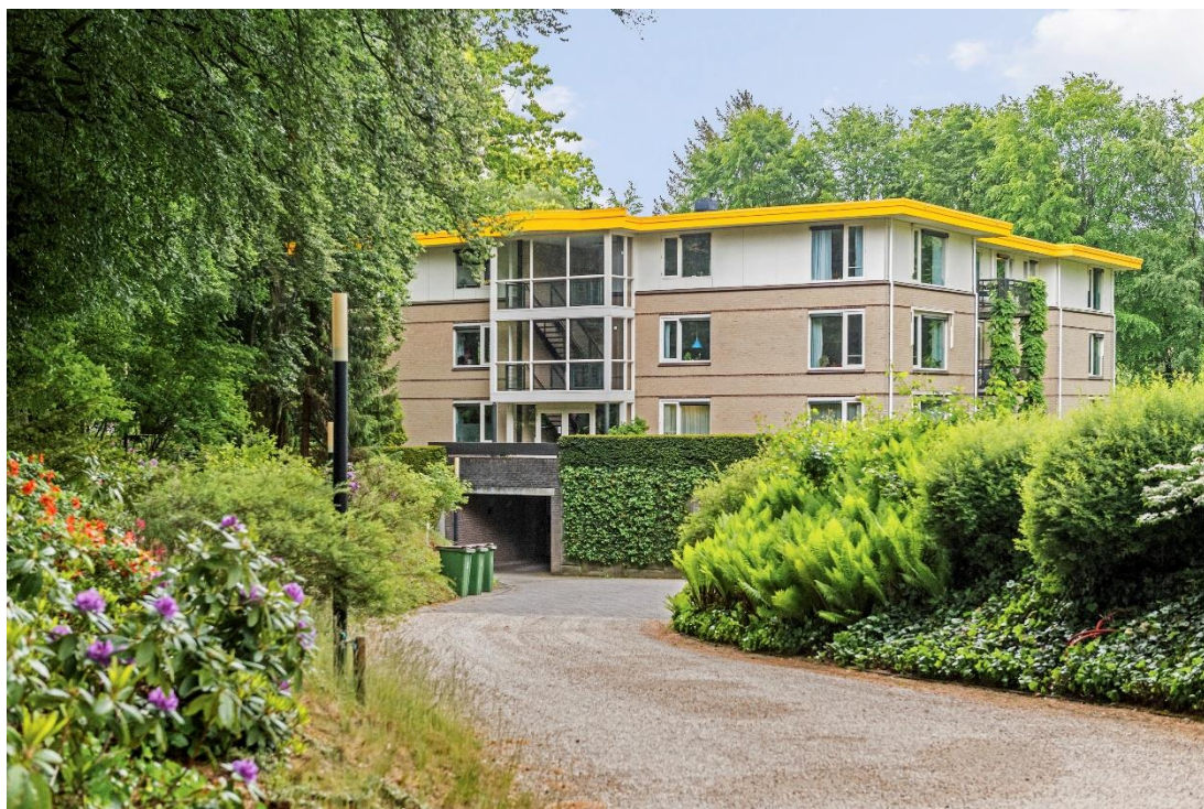
Inrit naar parkeergarage
