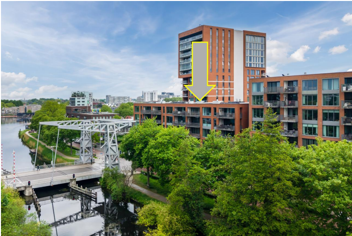
Gesitueerd op de vijfde verdieping (topverdieping)
