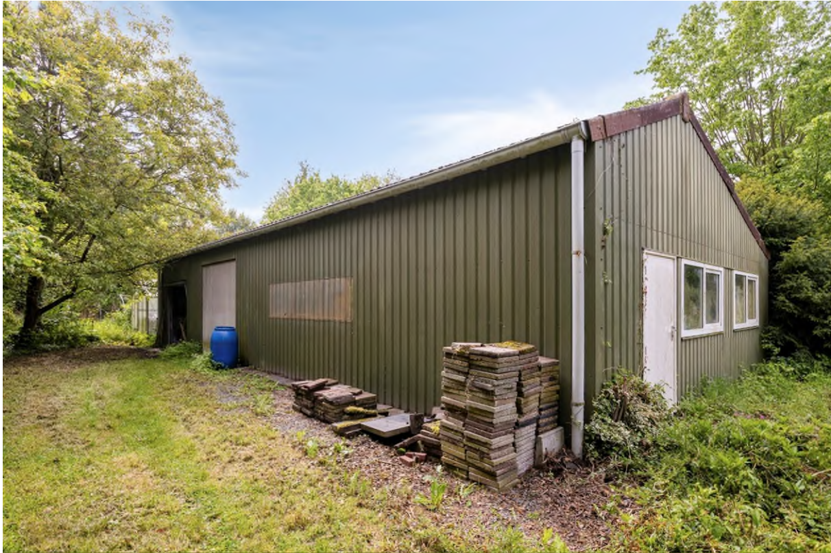
Zijaanzicht van de schuur / garage (voorzien van twee garageboxen).
