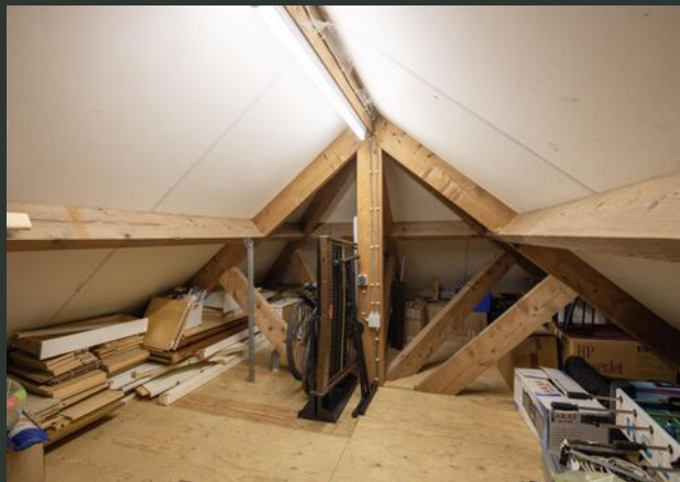
Bergzolder boven de garage
