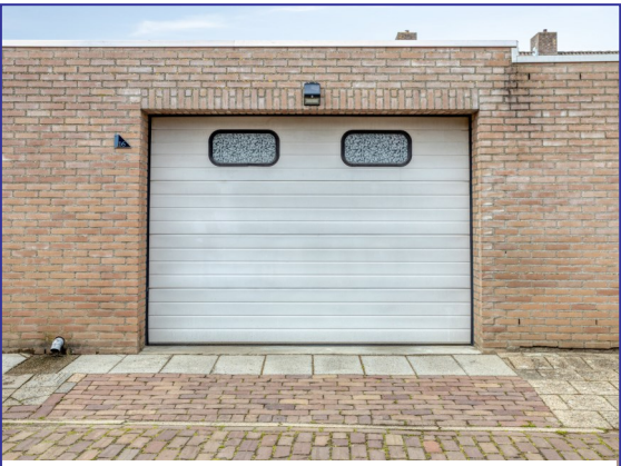
ELEKTRISCHE GARAGE DEUR
