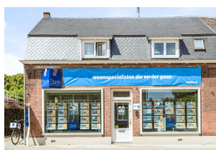
Sint-Michiëlsgestel Nieuwstraat 41a 073 - 551 00 50 infogestel@staete.nl
