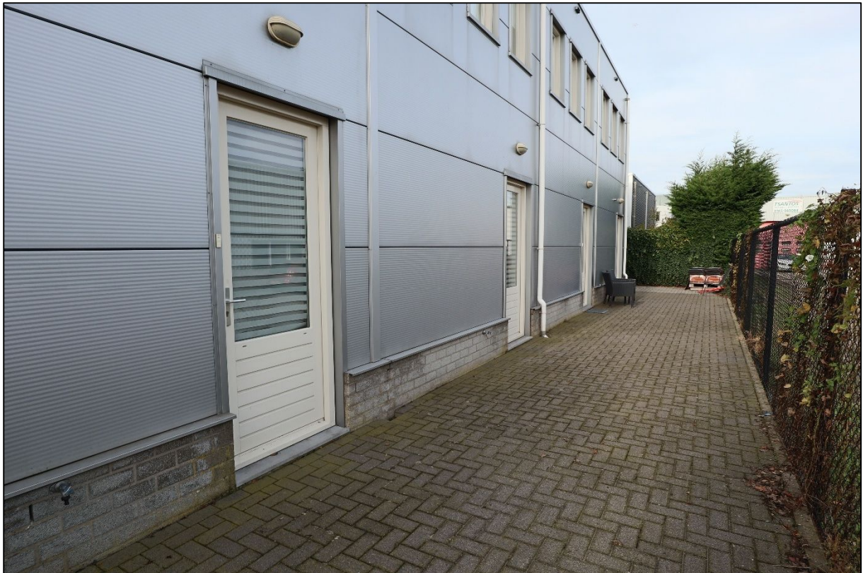
Bedrijfsunit 1 met eigen hal/entree op begane grond
