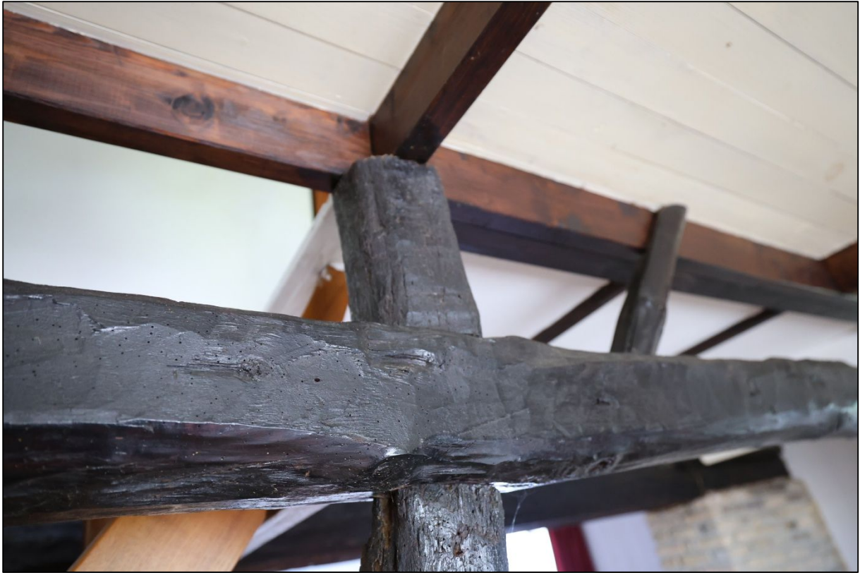
Balken in het zicht
