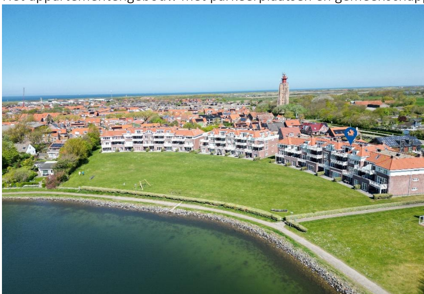
Achteraanzicht van het appartementengebouw.
