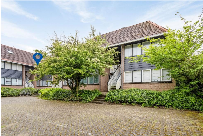
Achteraanzicht, via de trap toegang tot het appartement.
