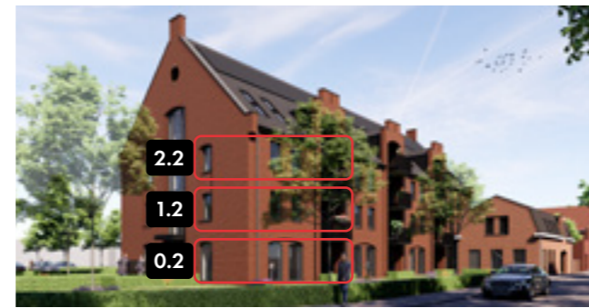
Ligging in het gebouw
