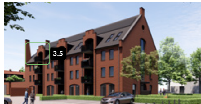
Ligging in het gebouw
