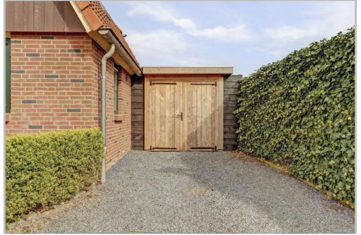
Aangebouwde berging met openslaande deuren.
