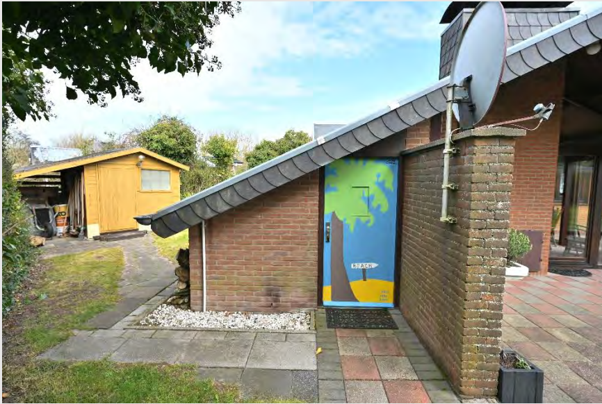
Die angebaute steinerne Schuppen.
