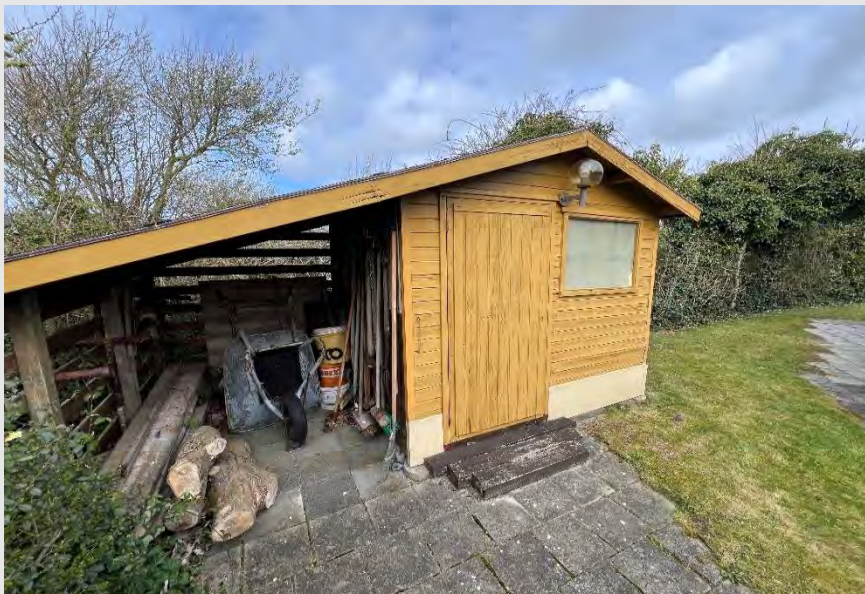
Das freistehende Gartenhäuschen.
