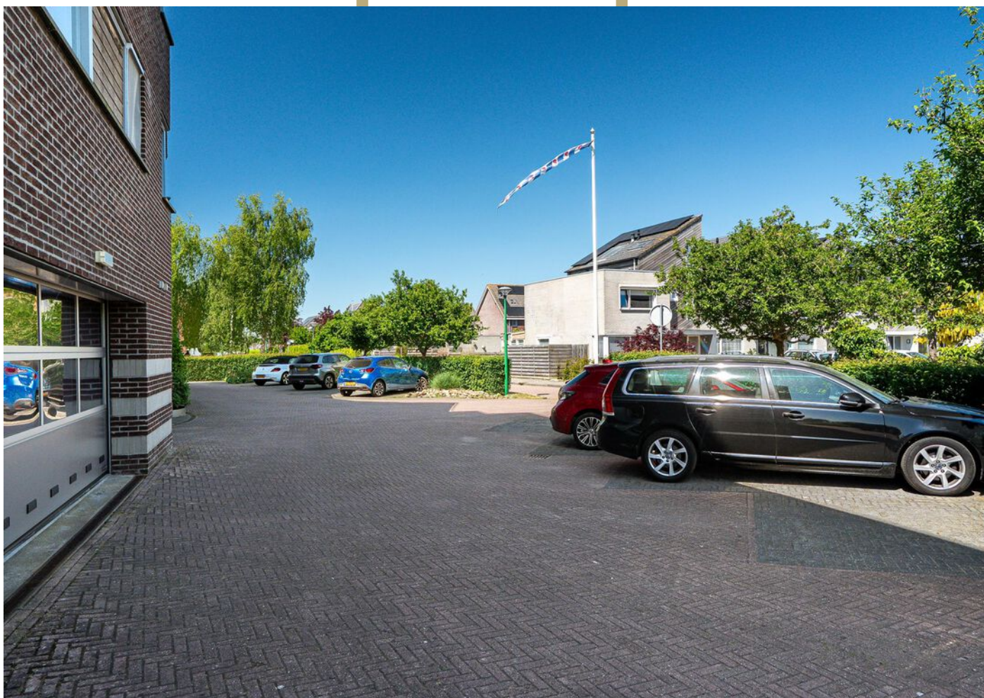
Centrale entree met parkeerplaatsen voor de deur.
