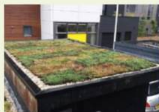
Bijgebouwen met sedumdak
