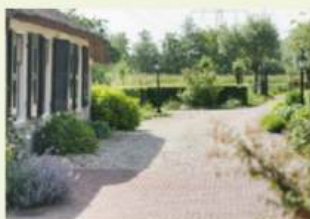
Halfverharding voor oprit
