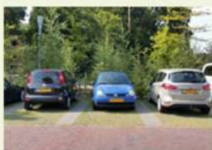
Parkeren op grasbetonstenen
